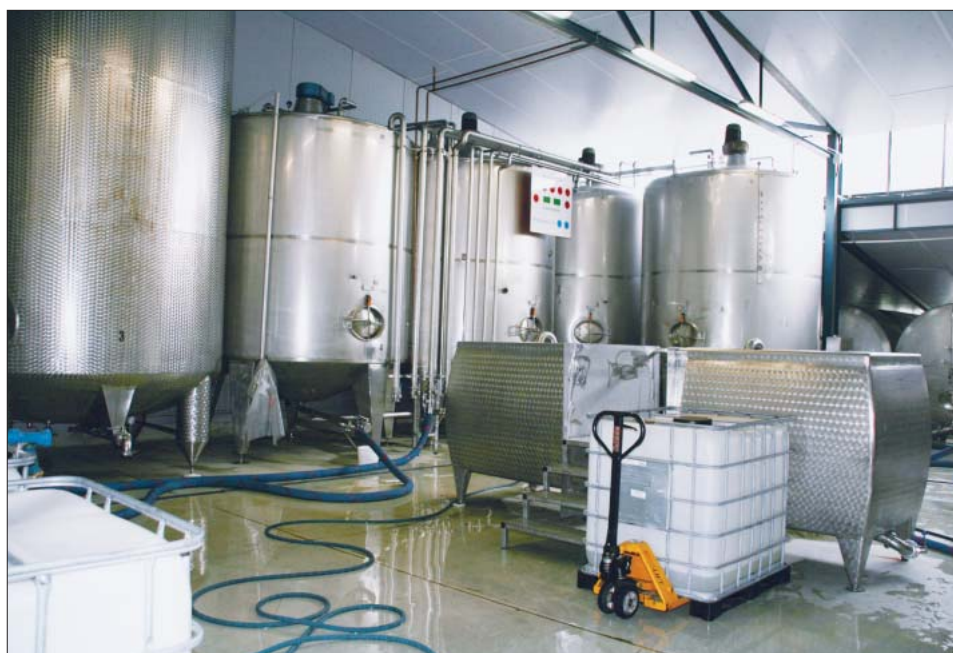
Bei der Produktion von Zuckersirupen wird das Produkt in die Lösewanne gegeben und dann mit einer Lösepumpe über eine Lösetankzuleitung in den Lösetank gepumpt.
